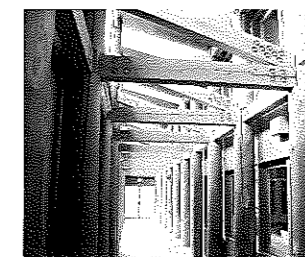
木造建築の校舎内
