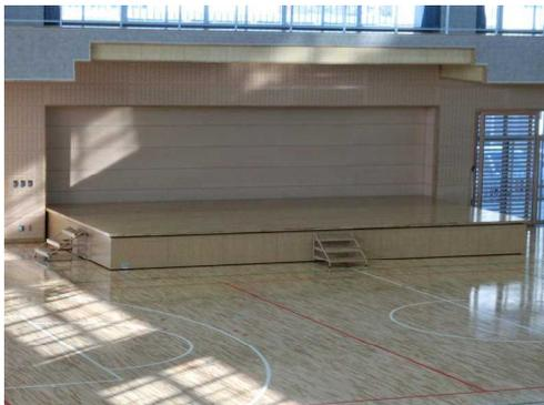
（電動式壁面収納折りたたみステージ）
