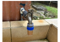
↑水道にもフィルター
