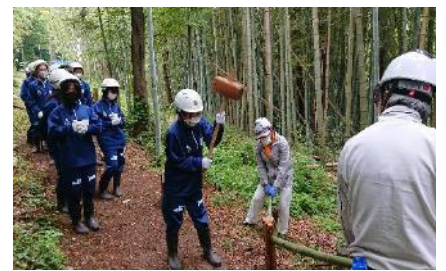
遊歩道整備のための杭打ち
