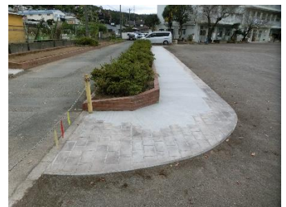
完成した歩道
