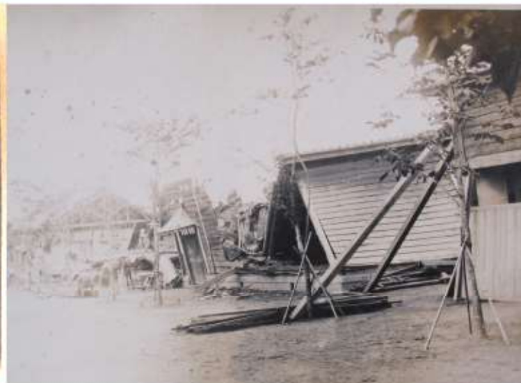
幸手小学校の校舎が倒壊した様子(「幸手町震災実況記念帖」より)
