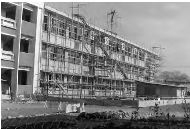
大畑小学校増築工事（1969年）
