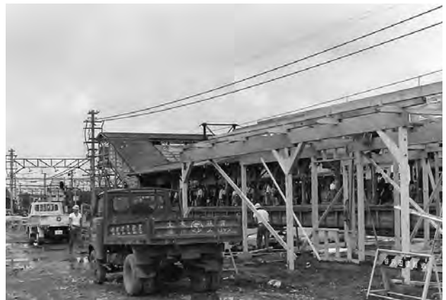
春日部駅西口開設工事 (1971年)
