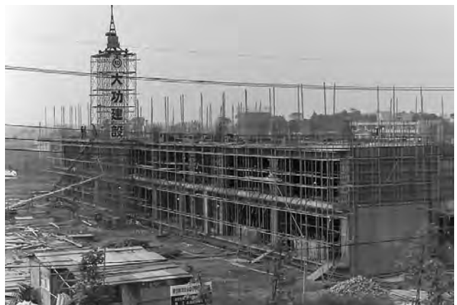
谷中小学校建設工事（1970年）
