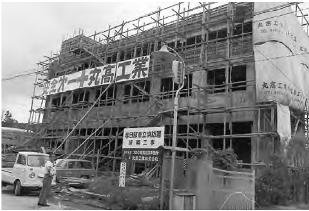
建設中の消防署新庁舎（現東分署・1968年）
