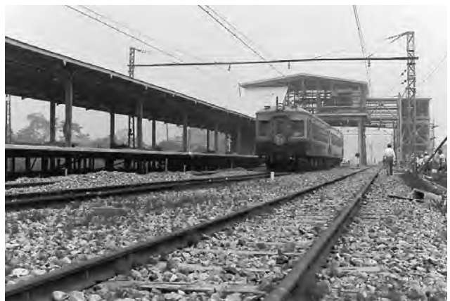
建設中の北春日部駅（1966年）
