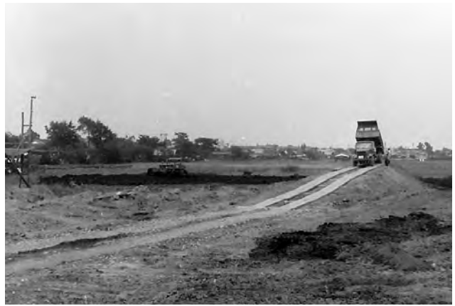
武里団地造成工事（1964年）
