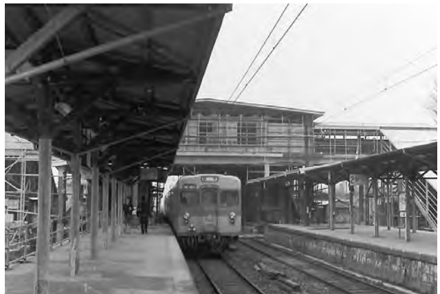
建設中の武里駅通路（1969年）
