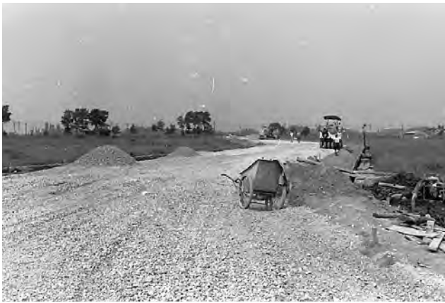
武里団地資材搬入道路（1964年）
