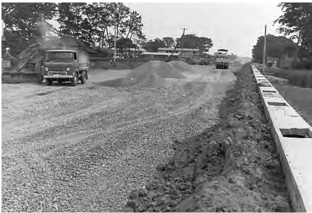
国道16号バイパス建設工事（1966年）
