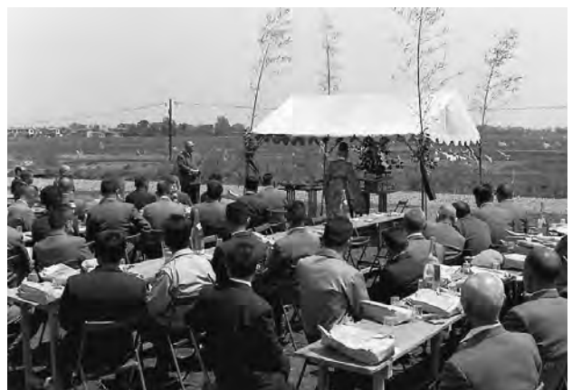
大沼幹線道路(西口駅前通り)の起工式(1965年)
