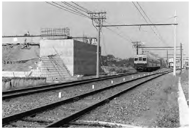
国道16号バイパス梅田陸橋建設工事（1966年）
