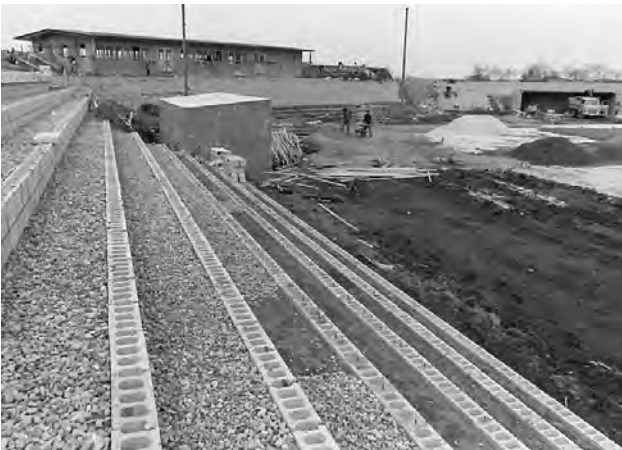
建設中の大沼運動公園グラウンド（1967年）
