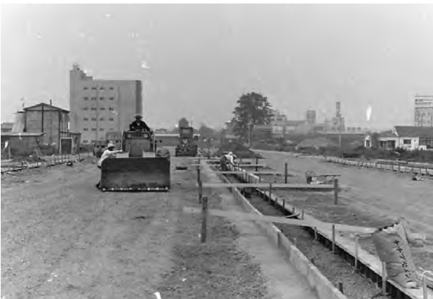
工事中の西口駅前通り第2期工事(1971年)
