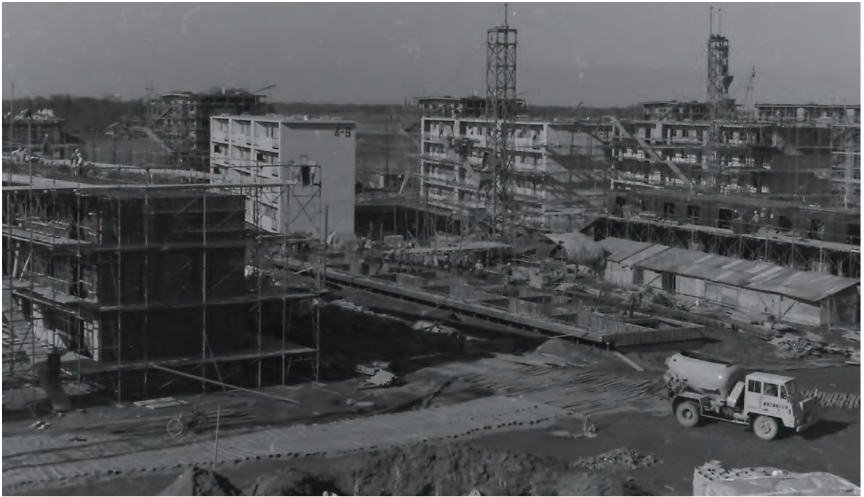
昭和 40 年（1965）建設中の武里団地
