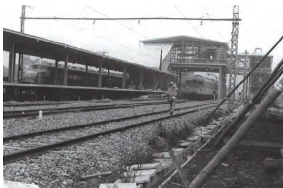
昭和41年(1966)建設中の北春日部駅
