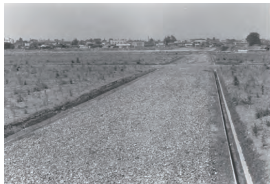
昭和40年(1965)春日部駅西口側の造成
