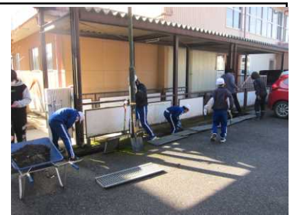
体育館通路側溝掃除
