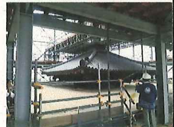
【東塔解体修復現場】
