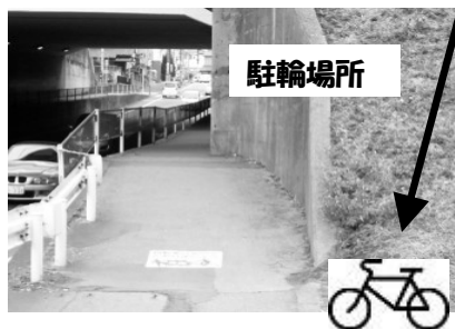
高架下入口大型マンション側
