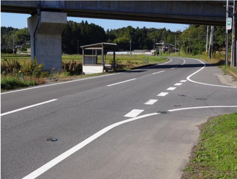
長南小⑧:長南・鶴枝線小金入口付近
